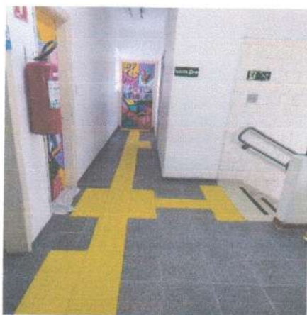
Hall Superior com piso tátil
